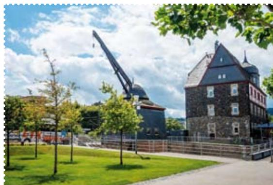
Der alte Binger Rheinkran ist ein hölzerner Turmtretkran aus der Zeit um 1787. Der Hafenkran mit drehbarem Ausleger und Kuppeldach steht neben der ehemaligen Zollverwaltung auf dem früheren Hafengelände.
